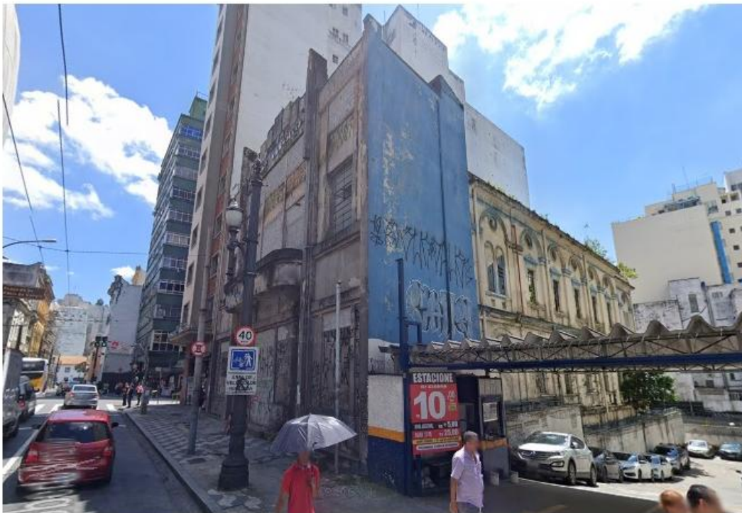
Prédio da Associação das Classes Laboriosas – Google Street View
